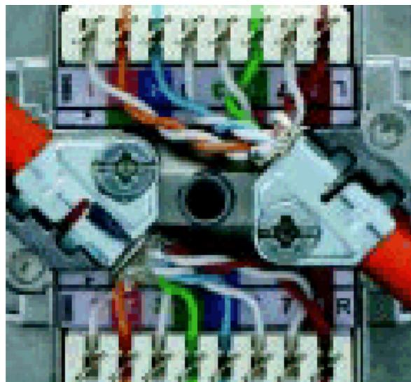
Placer les conducteurs selon l'illustration et la recommandation ci-dessous pour le code de couleur, ce faisant ne pas tendre trop fortement les différents conducteurs
